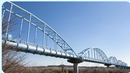
加古川水管橋
